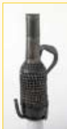
Lampa górnicza z 1880 r. skonstruowana przez francuskiego inżyniera M. Marsaut'a
