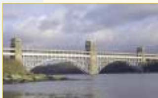
Most Britania po rekonstrukcji.
