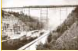
Stalowy wiadukt kolejowy Portage, Nowy Jork z 1875 r., zastąpił on wcześniejszy, wykonany z drewna.
